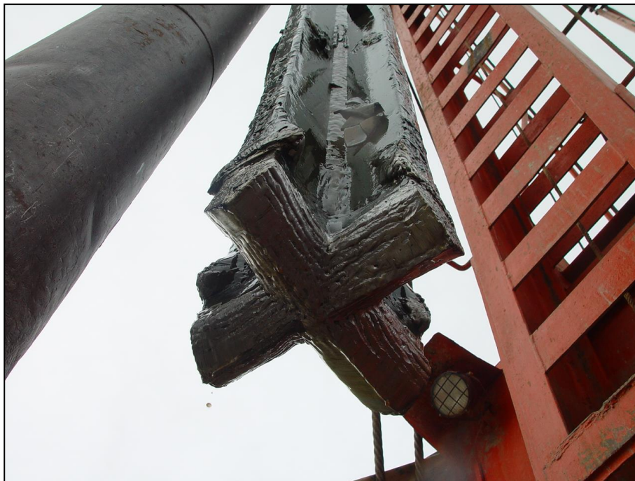
Foto 3.- Trépano de golpeo para el avance de la perforación.
