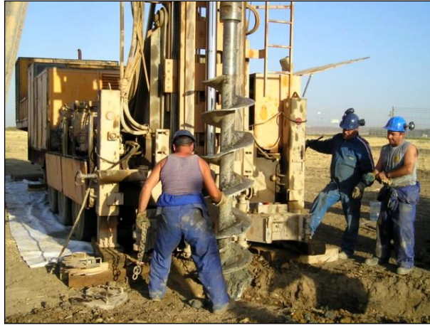
Foto 2.- Perforación de sondeos mediante hélice.
