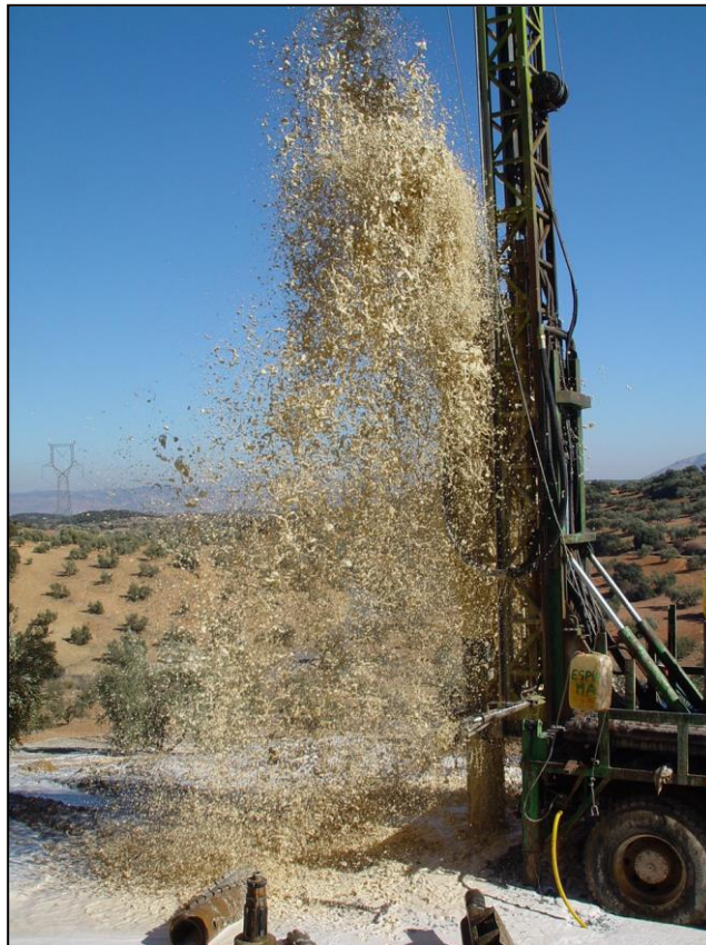
Foto 7.- Empuje del agua en la boca del sondeo por efecto del aire comprimido.
