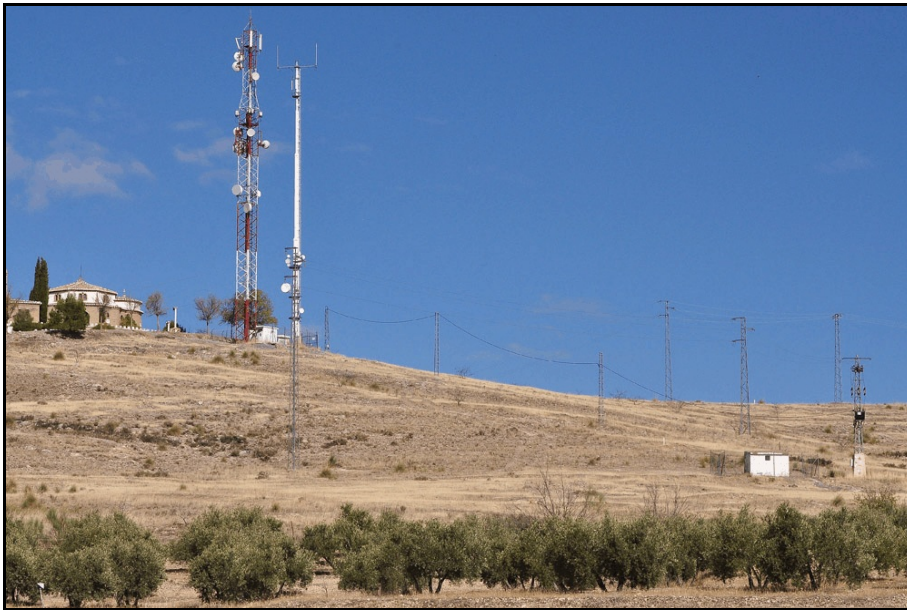
Foto nº 3: Sondeo de abastecimiento de Hernán Valle, a la derecha de la fotografía.
